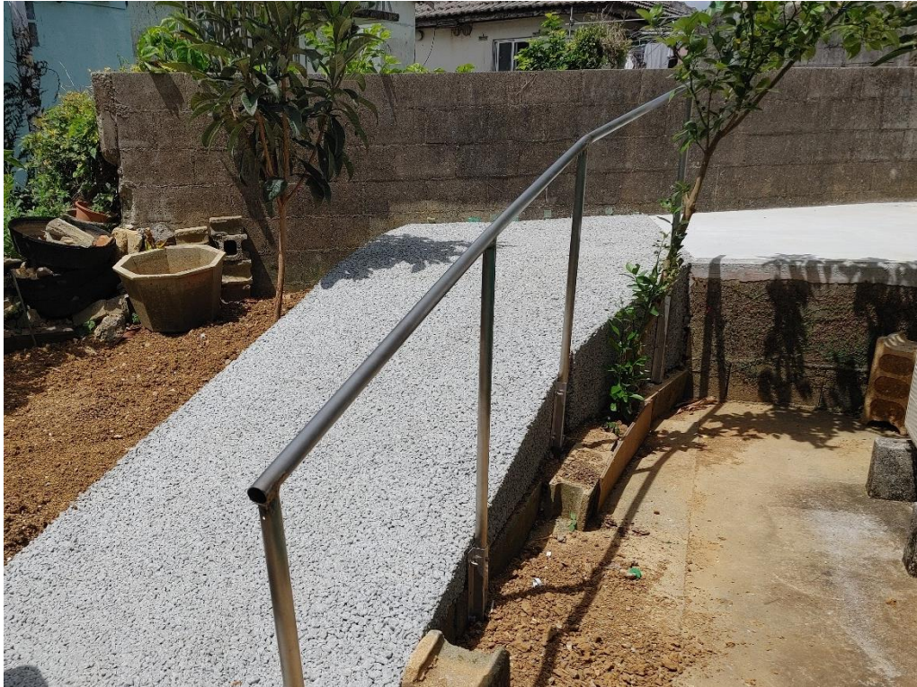
玄関付近スロープの施工事例
