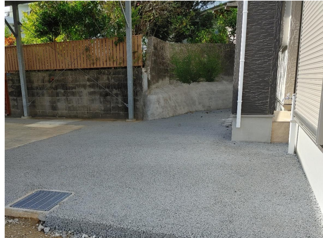
駐車場の施工事例 2
