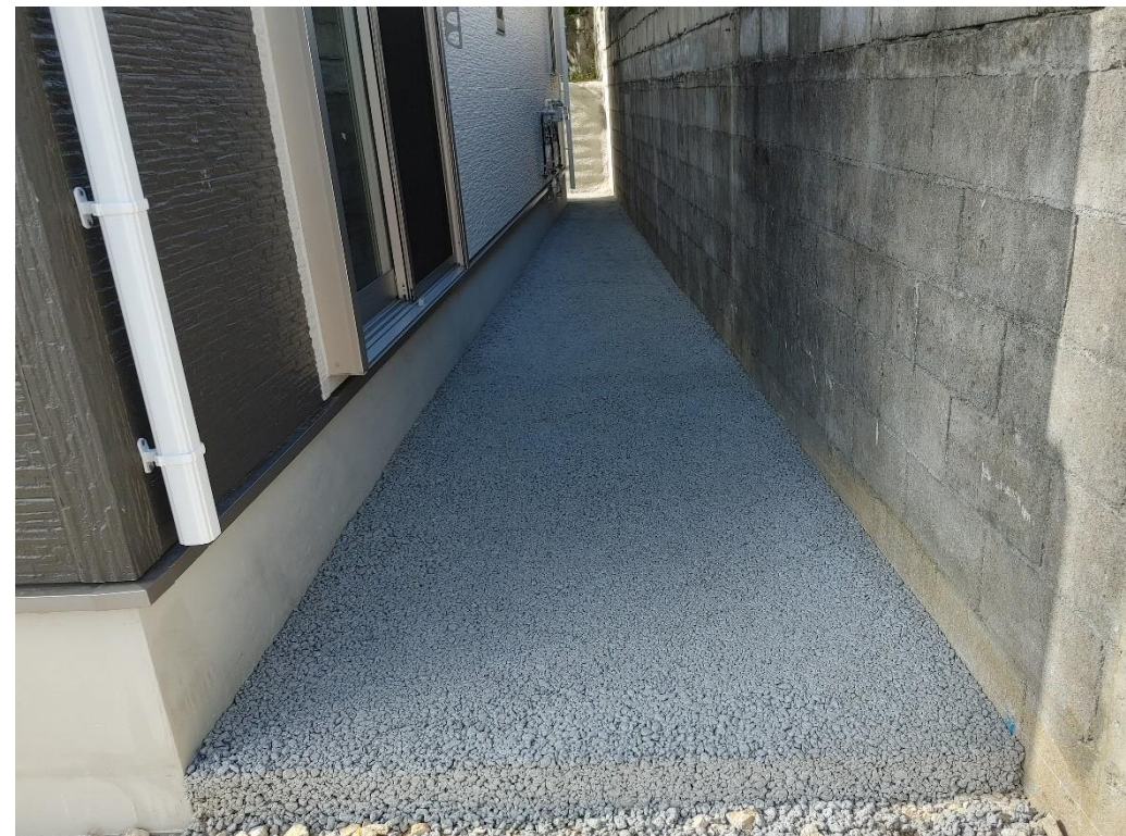
犬走りの施工事例
