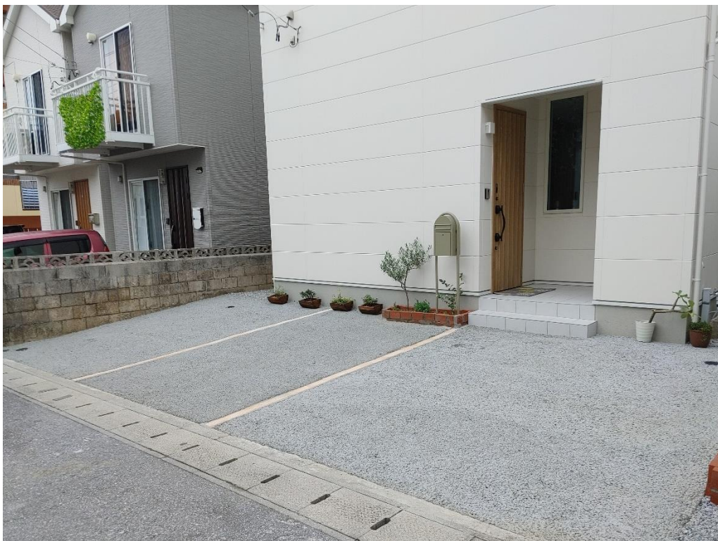
駐車場の施工事例 1
