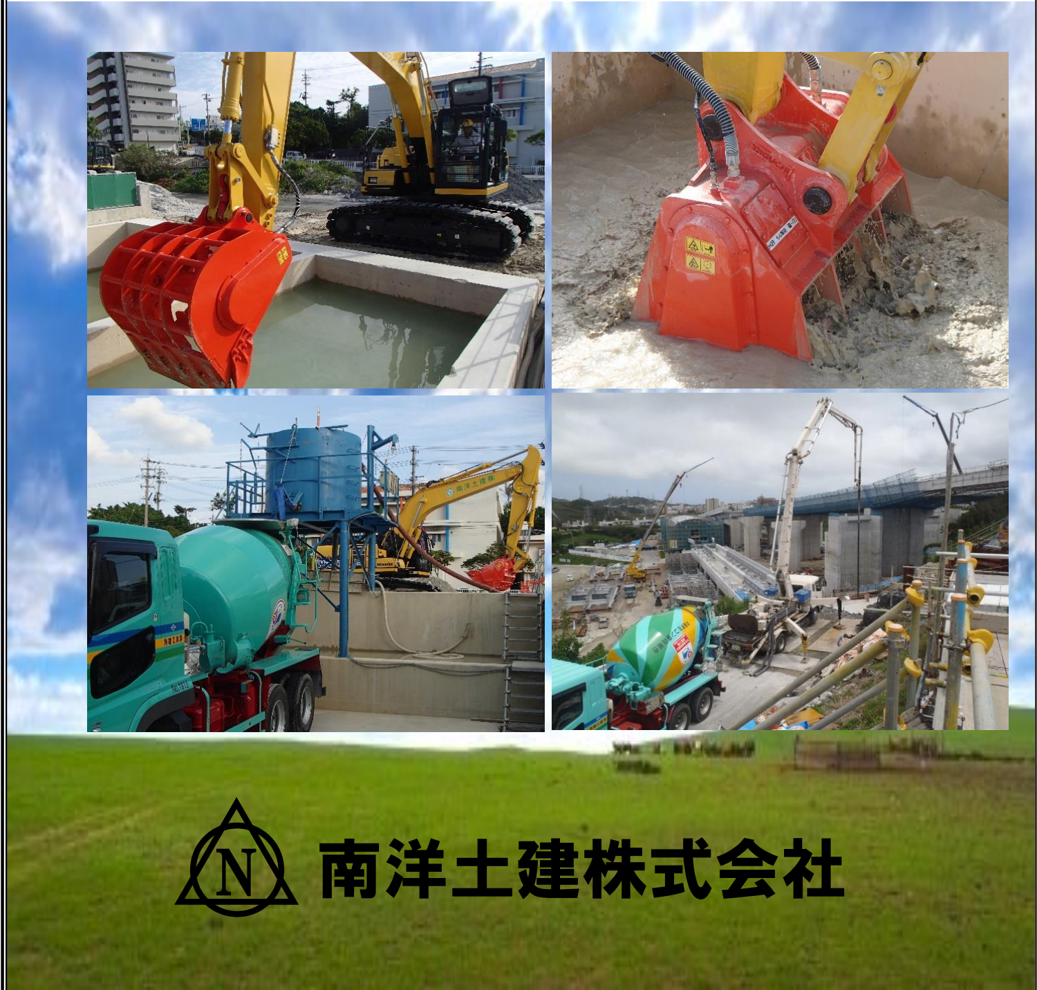
写真上段左：ミキシングバケット付き油圧ショベル(平成 29 年度補正ものづくり・商業・サービス経営力向上支援補助金申請 新車購入) 写真上段右：ミキシングバケットによる泥水攪拌状況 ・ 写真下段左：なんよう琉土製造プラント(南建工業棟内) 写真下段右：なんよう琉土打設状況< 浦添西原線都市モノレール建設工事 (地下構造物 H29-1) >
