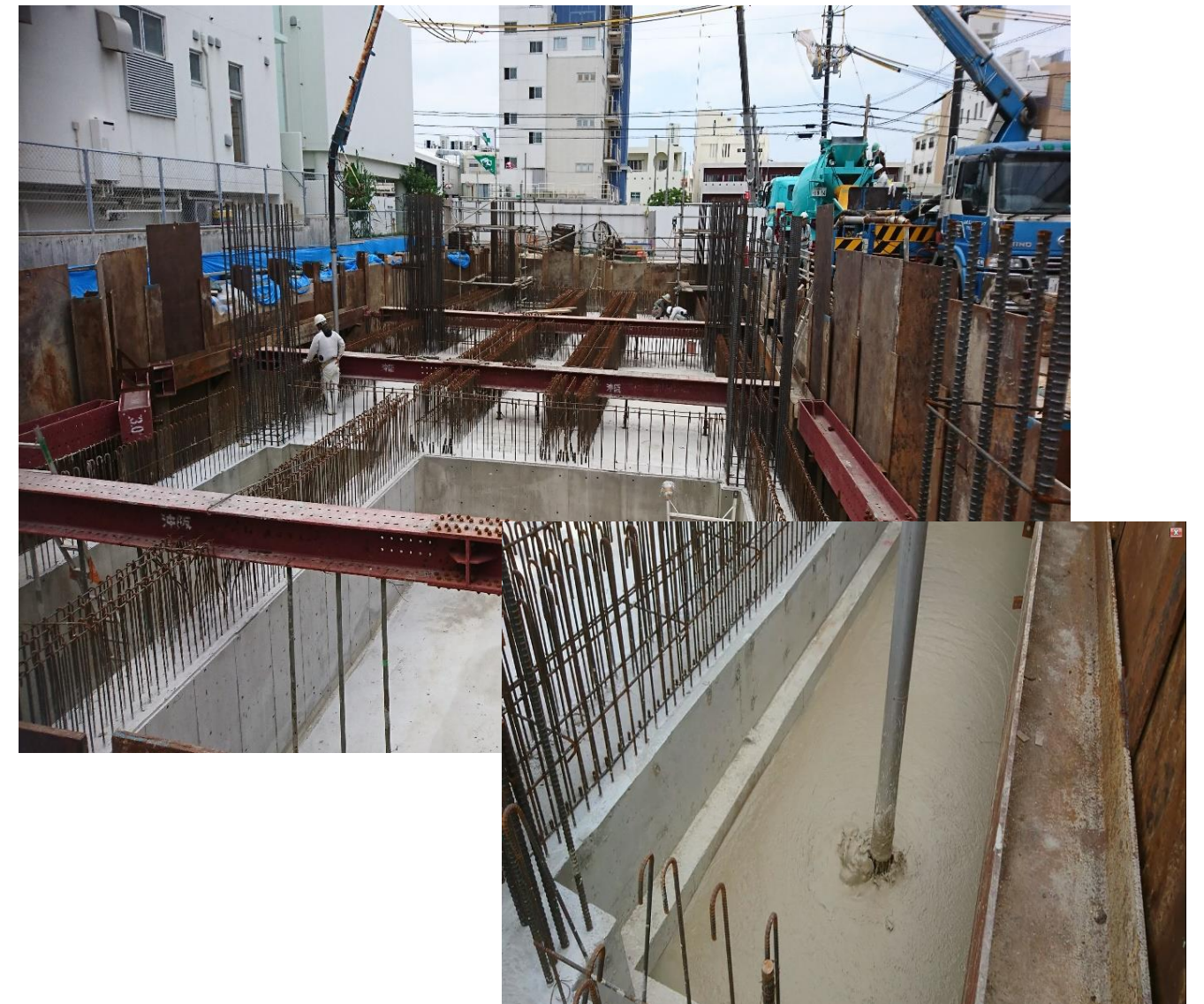
新築マンションの建設工事（民間工事） 狭隘部等の埋戻し
