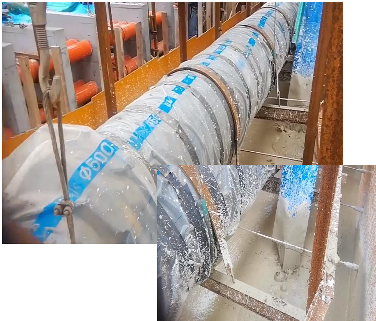
浦添西原線都市モノレール建設工事（地下構造物 H29-2） 埋設管の受け防御
